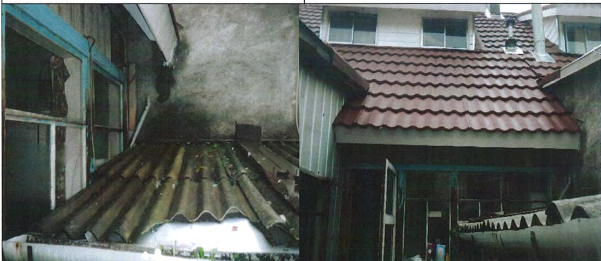
Foto N°3 Casa 6: Falta reponer canal de aguas lluvias
