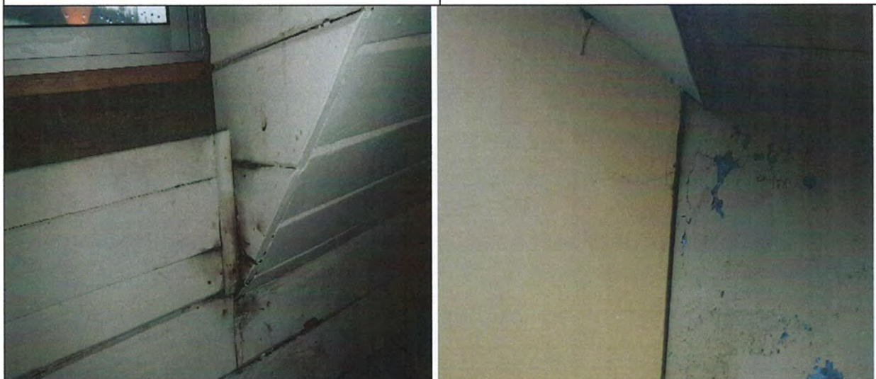
Foto N°10 Casa 14: Segundo piso excesiva humedad
