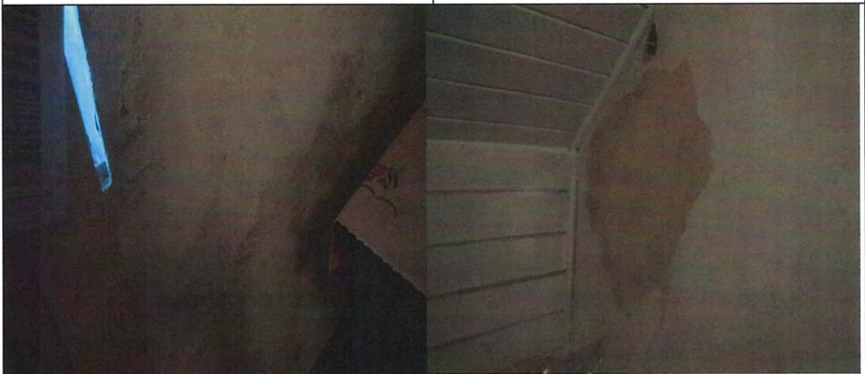
Foto N°8 Casa 14: Segundo piso excesiva humedad
