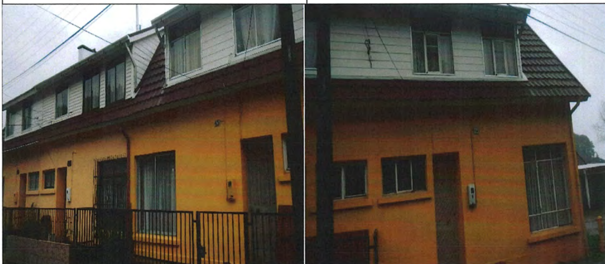
Foto N°5 Casa 12,13 y 14: Falta reponer canal de aguas lluvias
