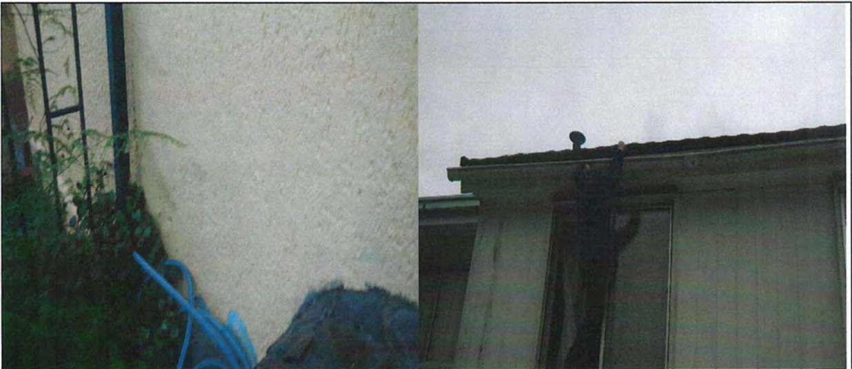
Foto N°6 Casa 12: Deficiente pintura exterior
