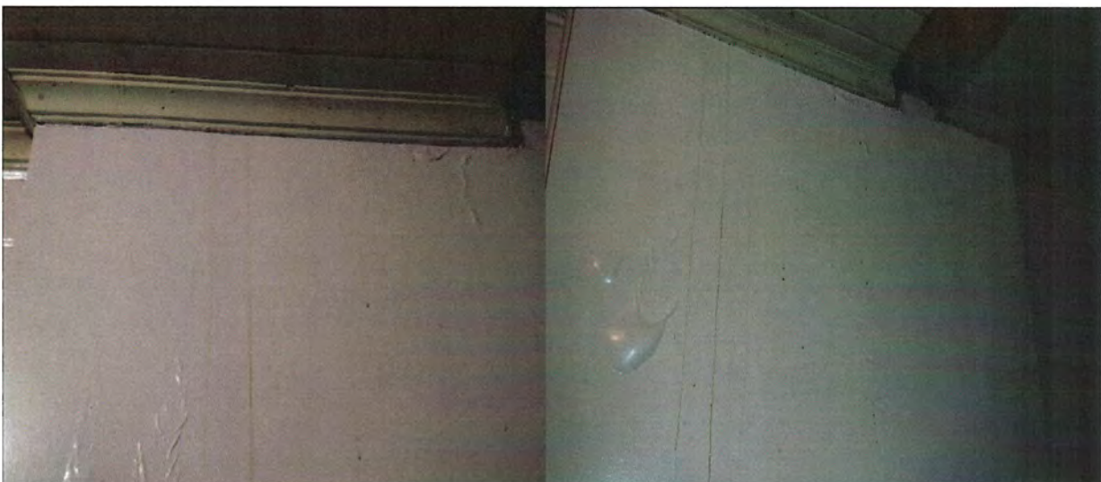
Foto N°1 Casa 1: Filtraciones en habitación segundo piso
