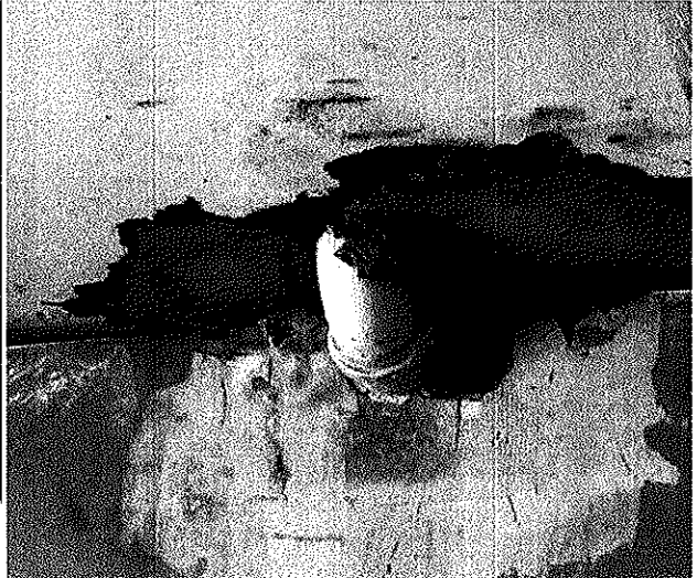
Foto N° 2 Ductos a la vista
